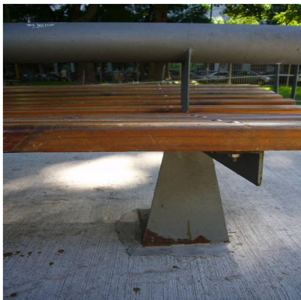
14-Bancos con incipiente oxidación en la
