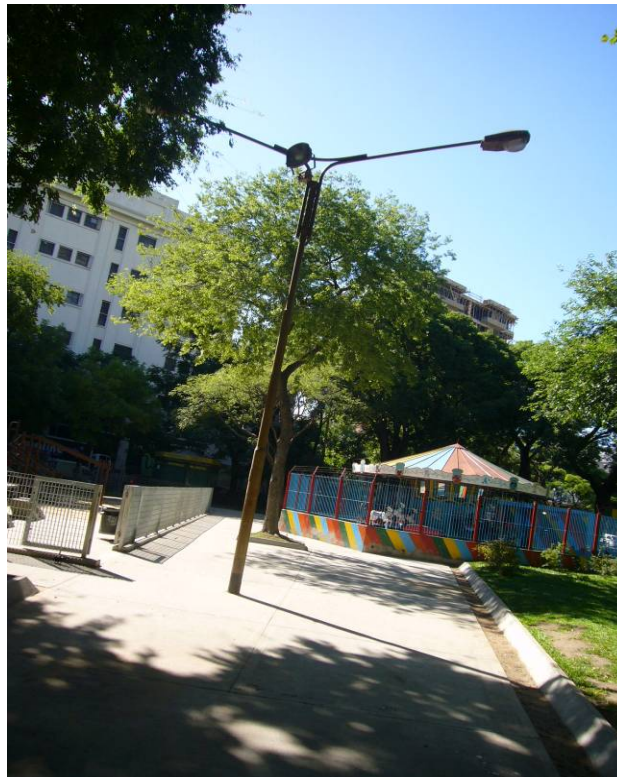
16- Luminarias de recuperación.
