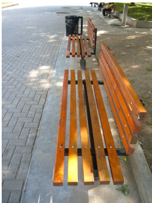
4- Bancos en buen estado. Solado intertrabado.
