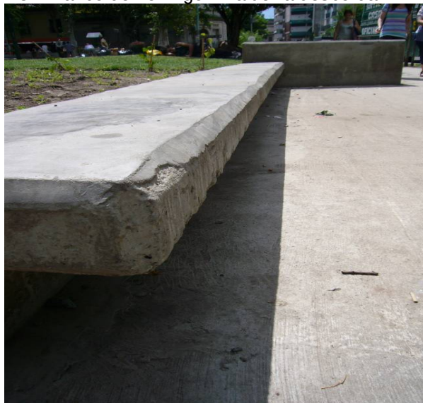
35-Banco de hormigón. Detalle de terminaciones.
