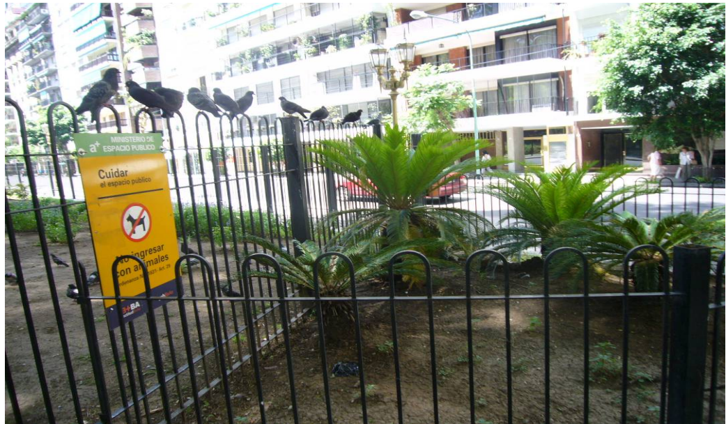
30- Agregado de rejas adicionales.
