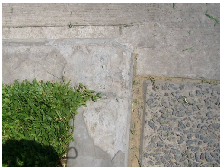
21-Detalles en cordones de cantero y solado.
