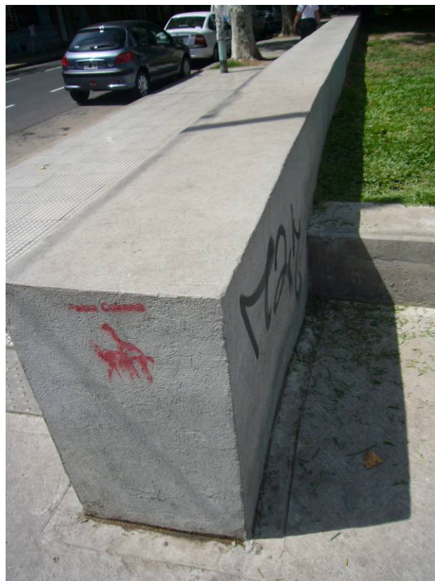
19-Muretes de hormigón / mampostería.
