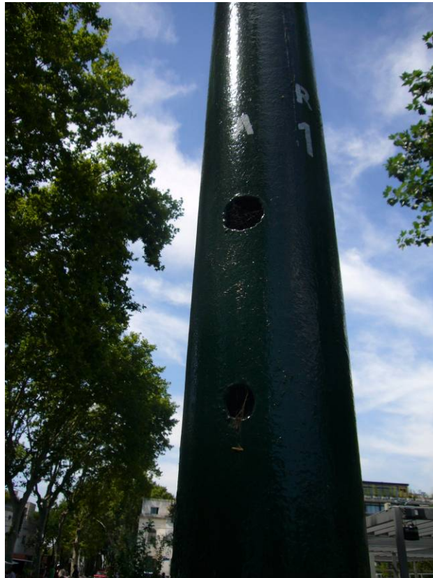
14-Las columnas de iluminación son de recuperación
