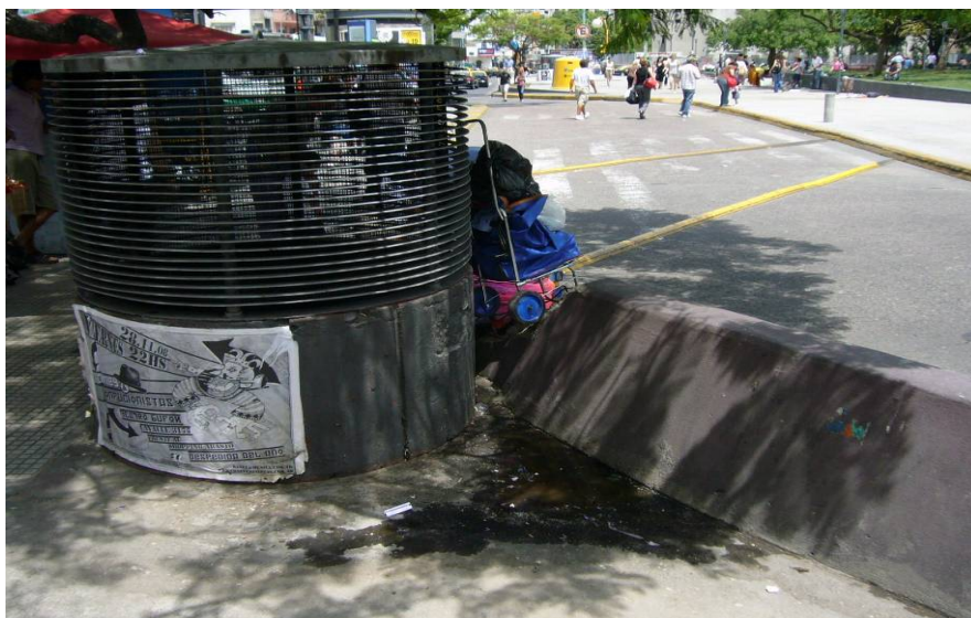
21- Mala ejecución de pendientes de drenaje.
