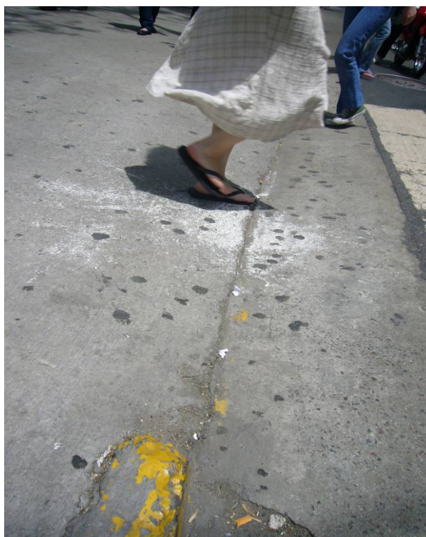
43- Rampa en vereda.
