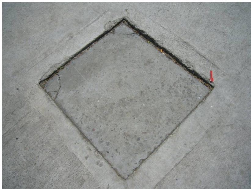
8- Tapa de cemento en desnivel.
