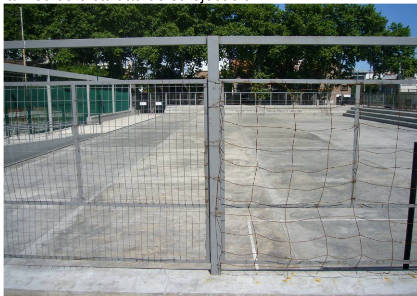
1-Reparación precarias rejas polideportivo
