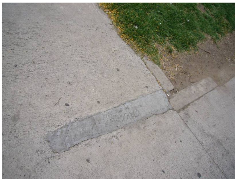
2- Cicatriz del retiro, a destiempo, de murete en el solado.
