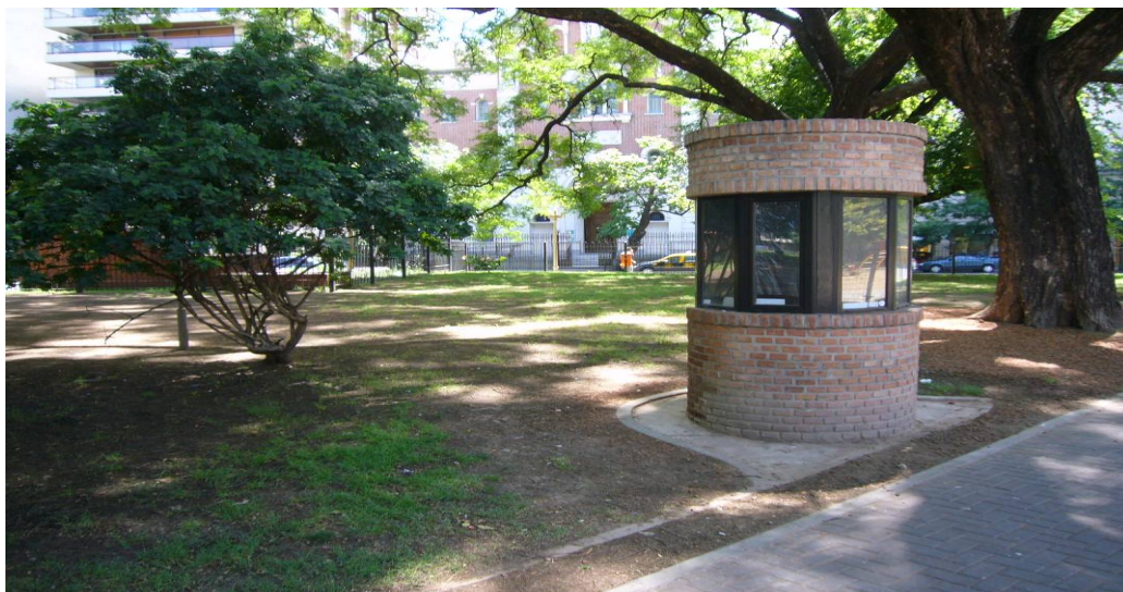
25- Cabina de seguridad.
