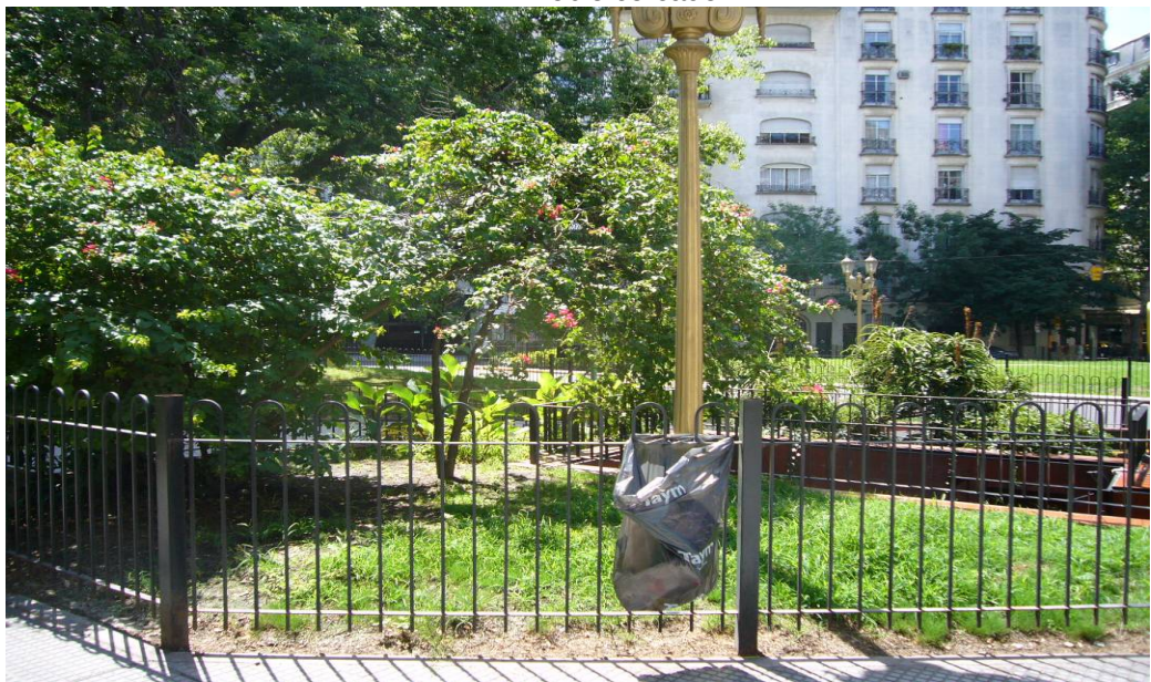
23- Cercado de plazoleta.
