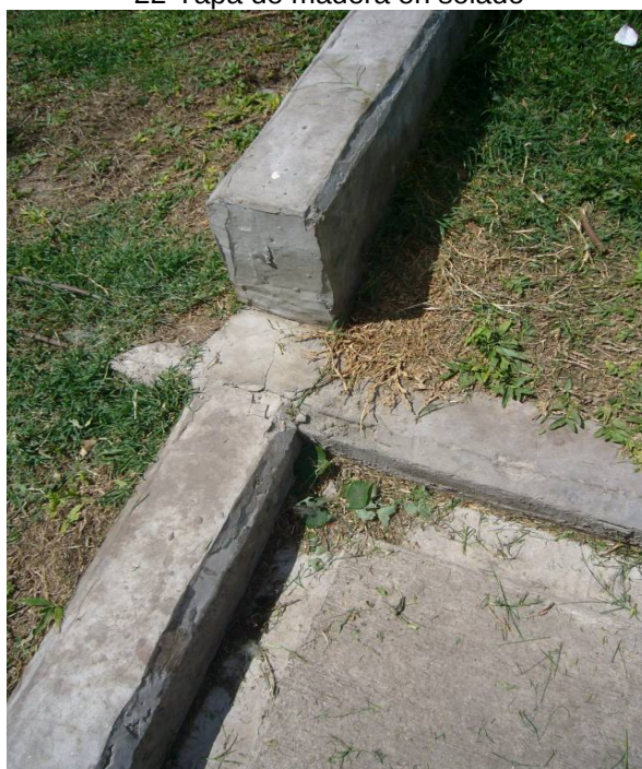
23-Detalles del hormigón.
