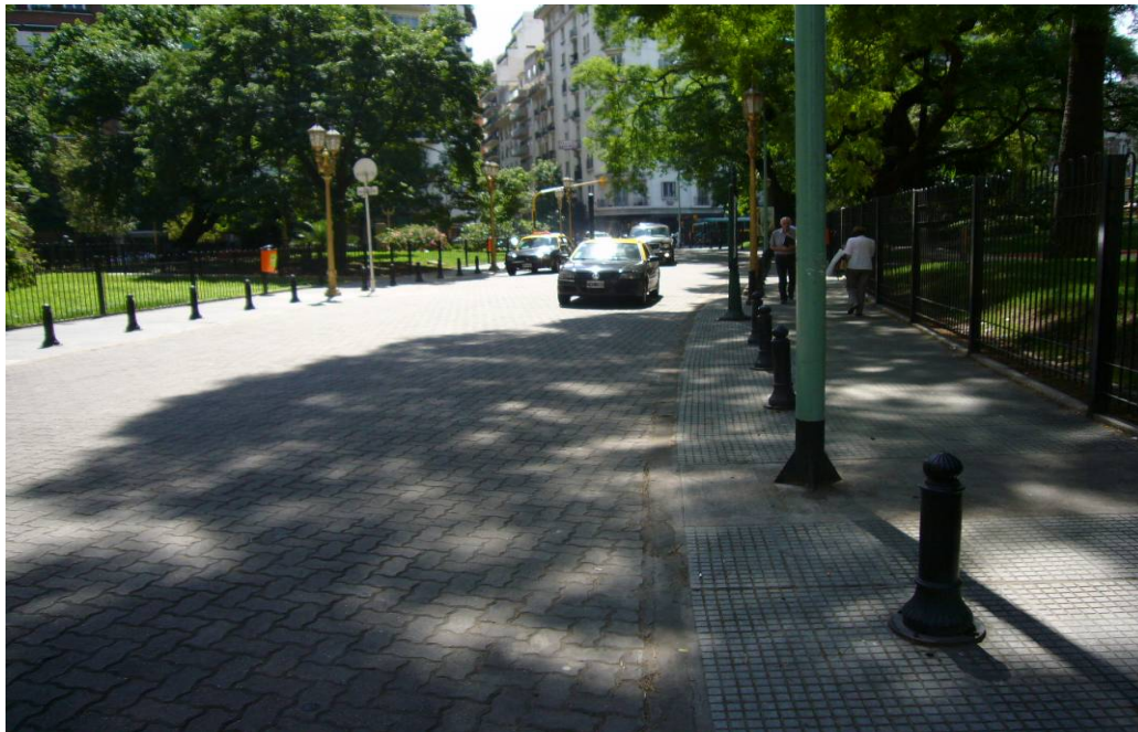
36- Unificación de niveles de calzada y vereda.
