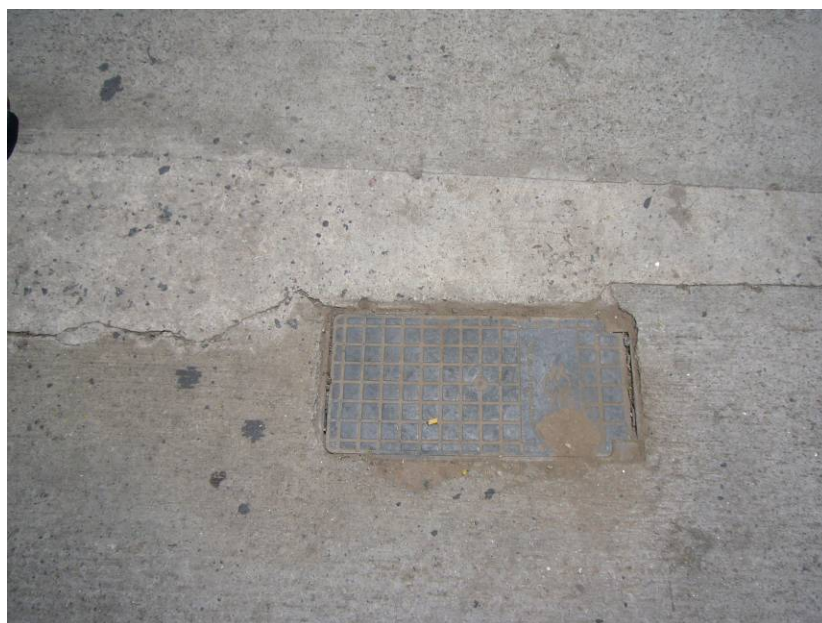
60- Terminaciones en vereda.
