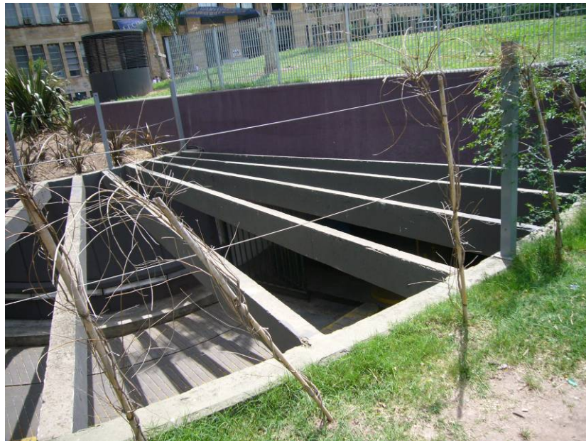
3- Alambres "de seguridad".
