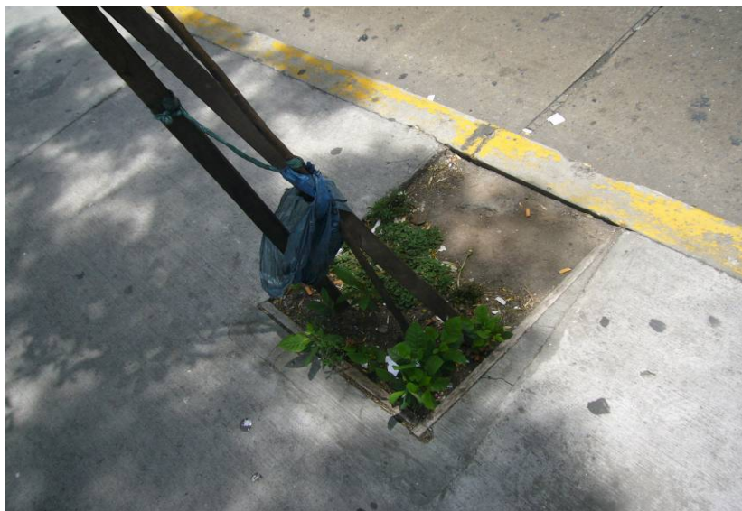
44- Mala terminación de vano para los árboles.
