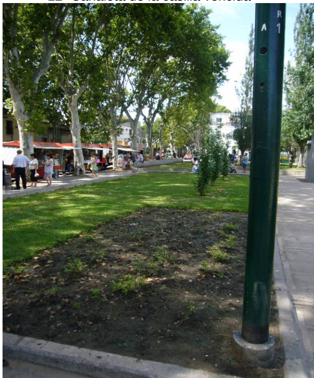
13-Correcta protección de la base del piquete.
